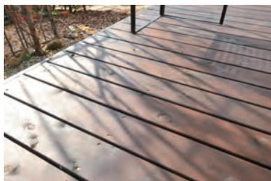
組み上げる前と完成後、二度塗装を行うことで塗り残しをなくし、耐久性を向上させる
