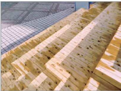
写真 3 木質後の階段部
