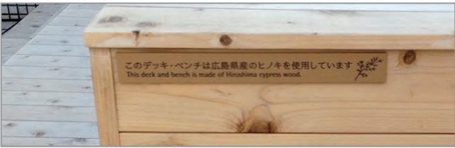
写真 1 階段部の表示
