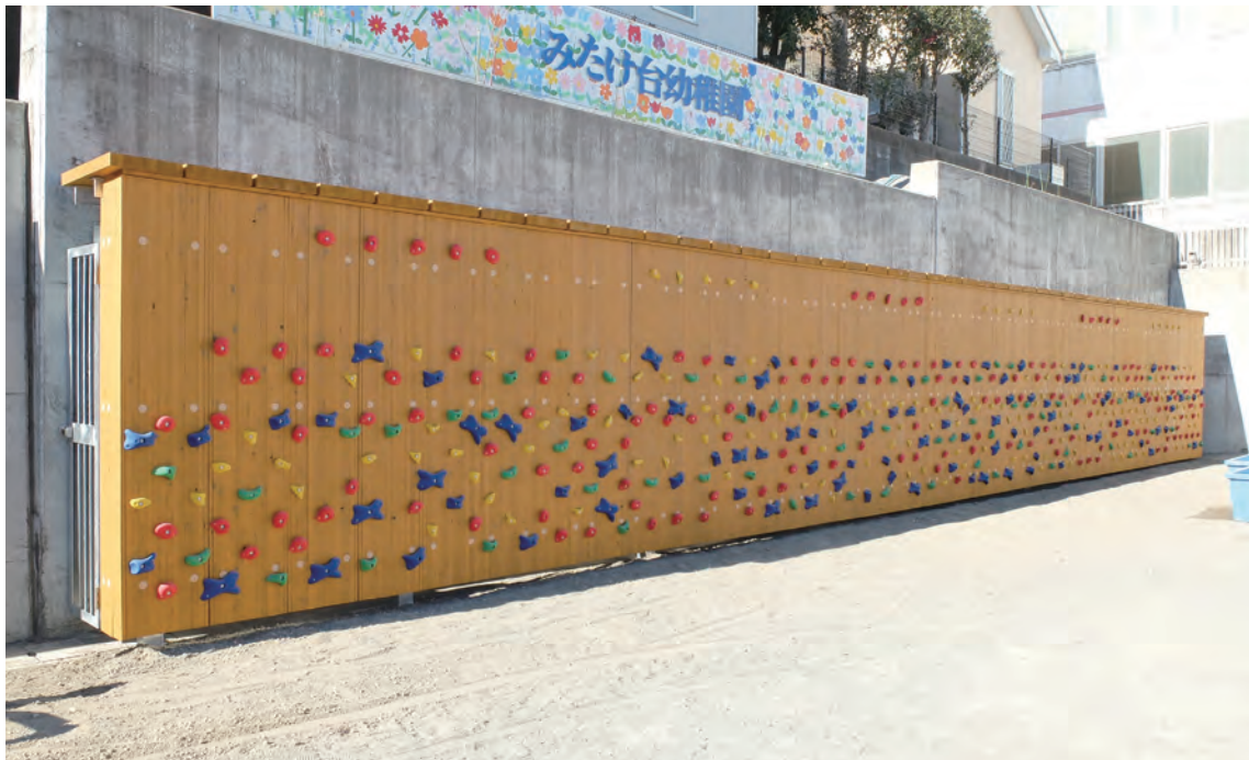
写真：設置した施設全景 (スギ DLT を用いたボルダリングウォール)
