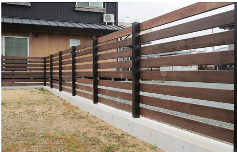
コンクリートの基礎にアルミの支柱を立て、板を取り付けた
