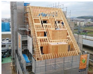
施工中の様子
