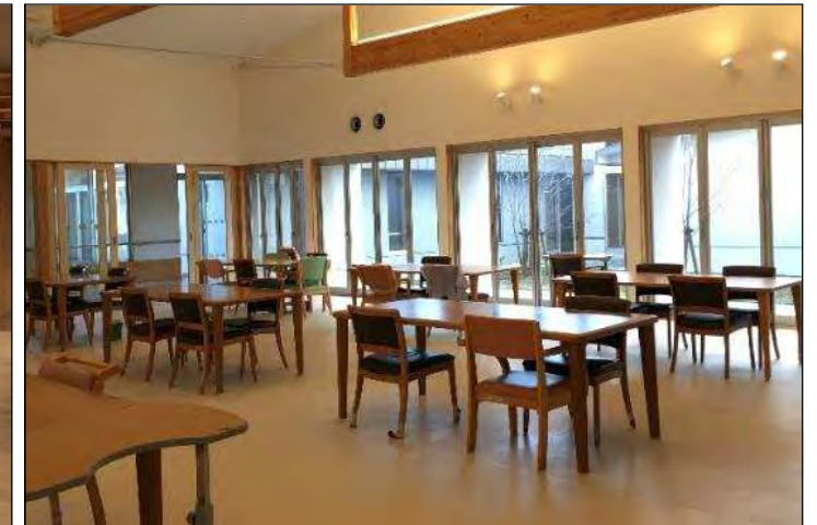
食堂の床は、清掃面からフローリングではなく長尺シートを採用
