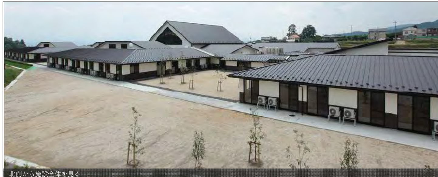
北側から施設全体を見る
