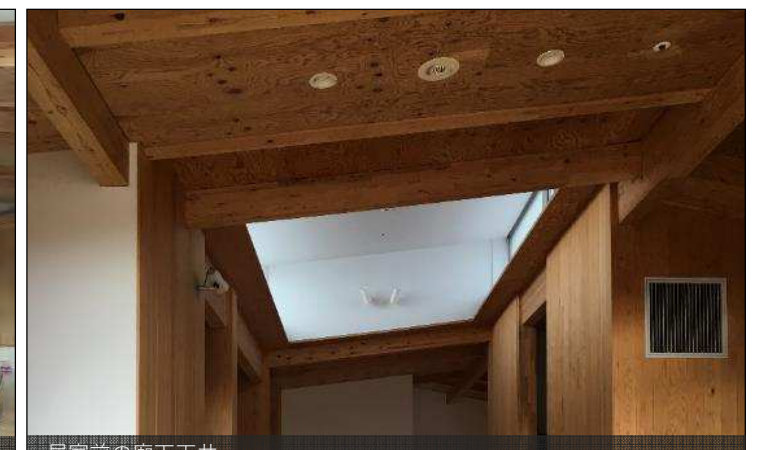
居室前の廊下天井
