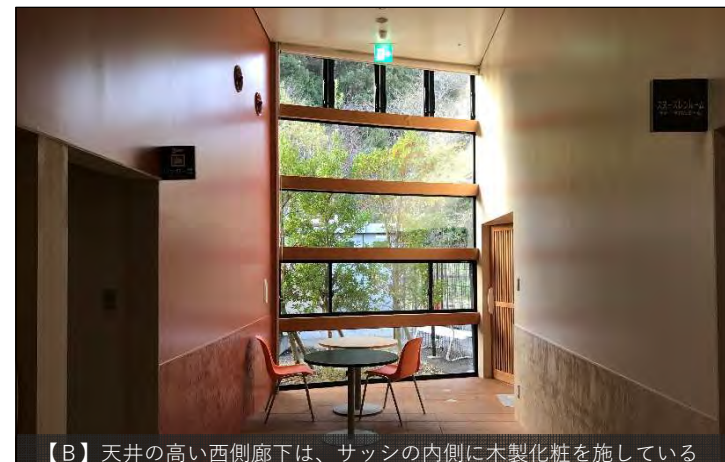
【B】天井の高い西側廊下は、サッシの内側に木製化粧を施している
