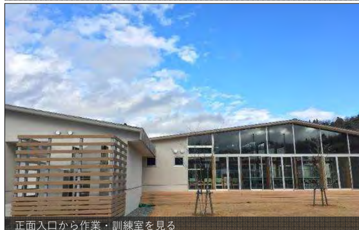
正面入口から作業・訓練室を見る
