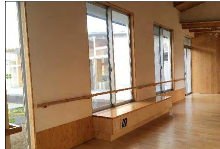
入所者の破壊行為予防のため、内部に空調設備を備えた木製ベンチ
