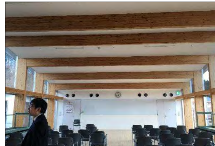
大断面集成材を用いた門型フレームによる大空間（作業訓練室）
