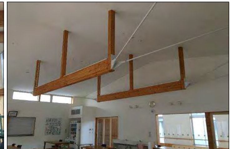
山型の梁を用いたサスペンション構造による大空間（食堂）
