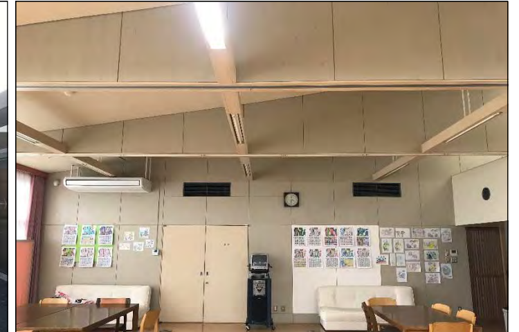
【B】作業室の内壁は構造用合板で仕上げている
