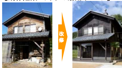
改修前(空き家)
