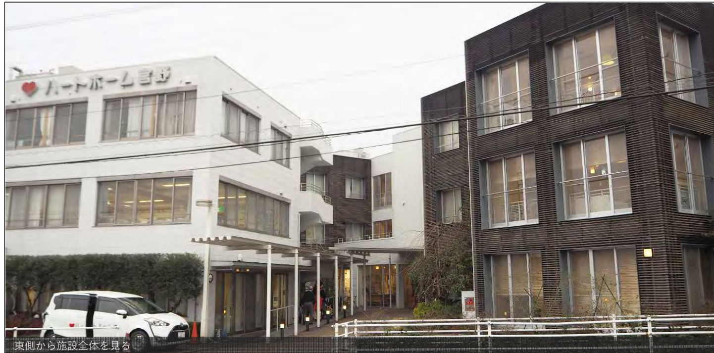
東側から施設全体を見る
