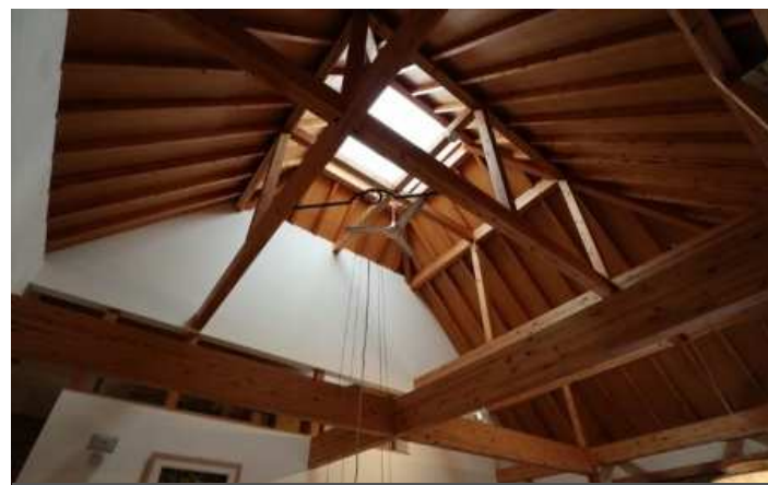
ダイルーム天井見上げ
