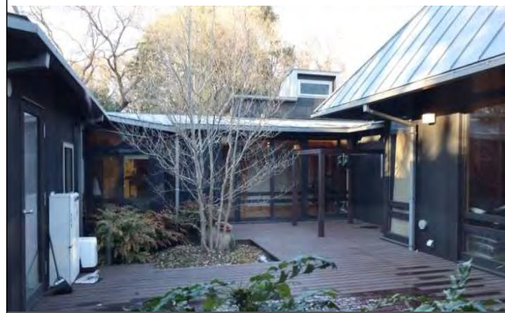
中庭を介して親密感のある病棟部分（左及び奥）、ダイルーム（右）を見る
