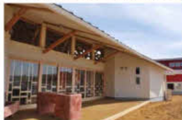
遊戯室の舞台奥の緑側部分外観
