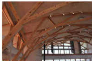
スギ120角製材の樹状方杖架構による13.65mスパン遊戯室
