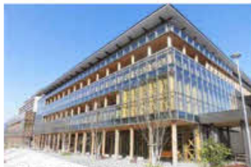
KB-WALL 耐力壁を3階全面に用いたファサード外観
