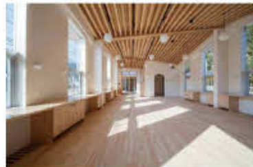
ついでに写真：小断面のスギ製材のジョイント梁による緩やかなHPシェル造り壁
