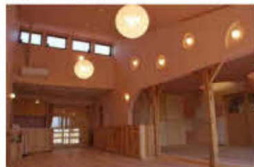
岐阜県産スギ製材を柱や家具に用いた保育室
