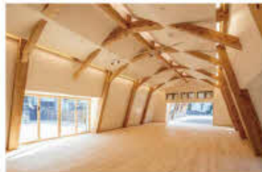
2階遊戯室部分の1階遊戯室側シガーストラスの小断面と内掛けの合木せせによる梁
