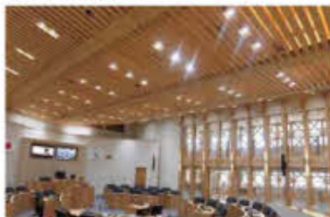
ルーバー天井・ヒノキ角材による弓形張弦梁の下弦材
