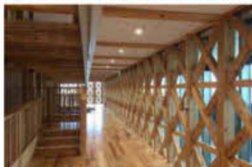
スギ90mm角材3段たすき掛け筋かい耐力壁[KB-WALL]
