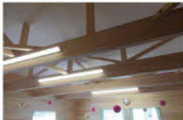
静岡県産材の富士ヒノキを構造材に使用したプレイルーム
