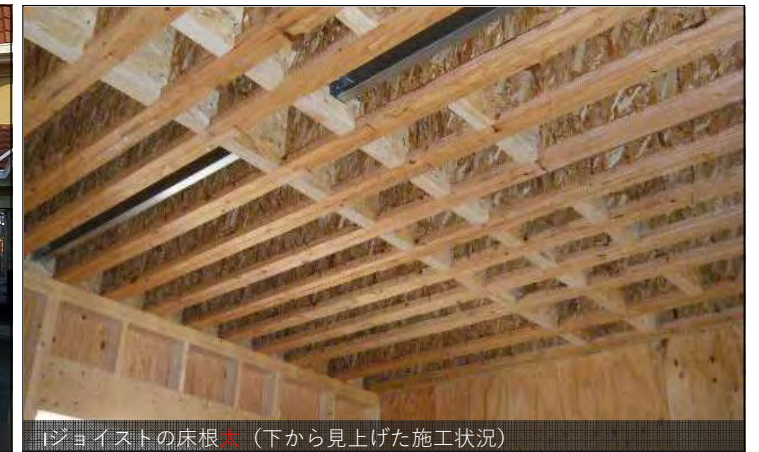
Iジョイストの床根太 (下から見上げた施工状況)
