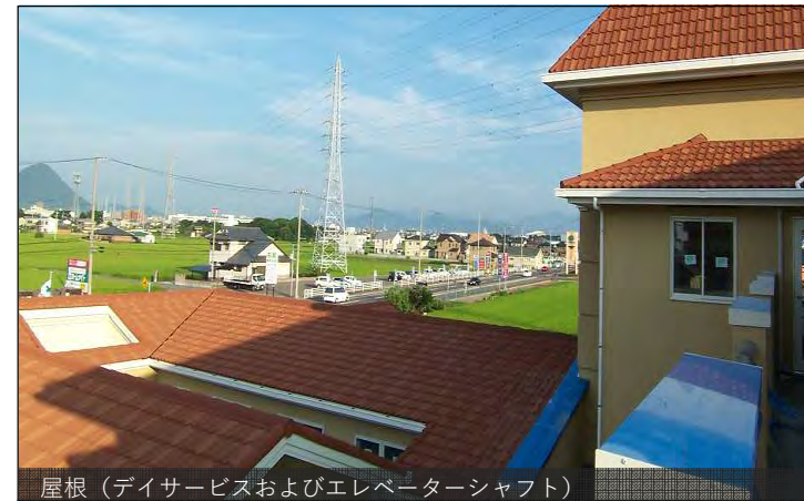
屋根 (デイサービスおよびエレベーターシャフト)
