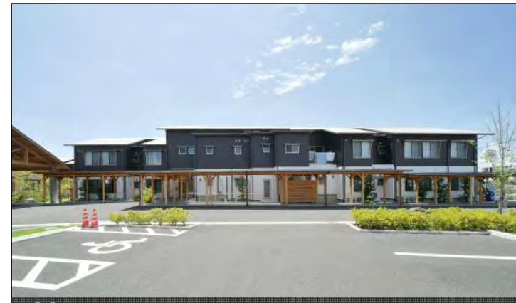
【A】駐車場から北棟を見る
