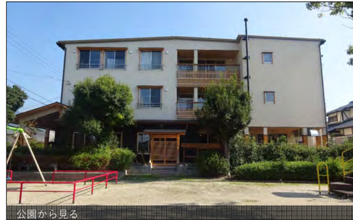
公園から見る
