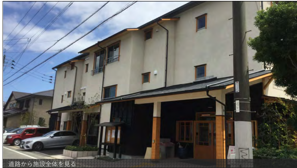
道路から施設全体を見る
