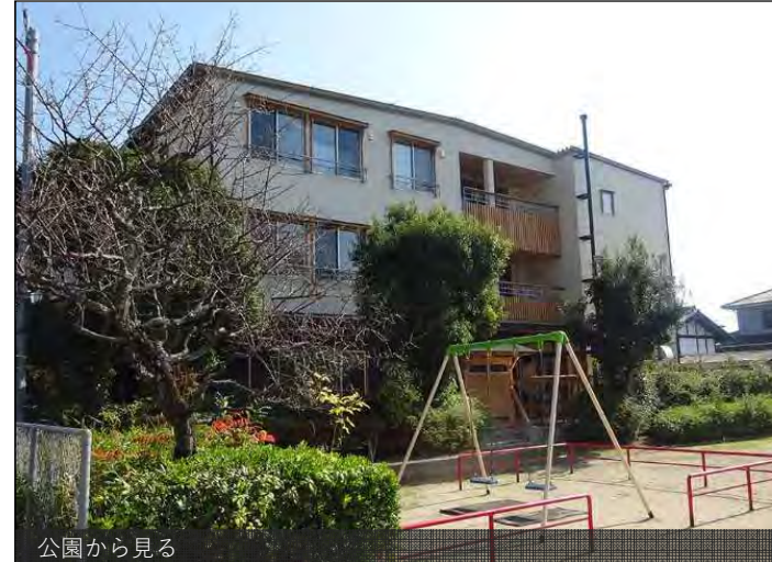
公園から見る
