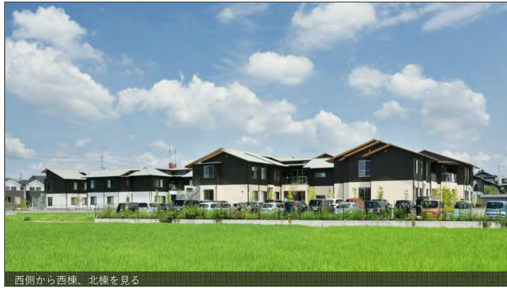
西側から西棟、北棟を見る
