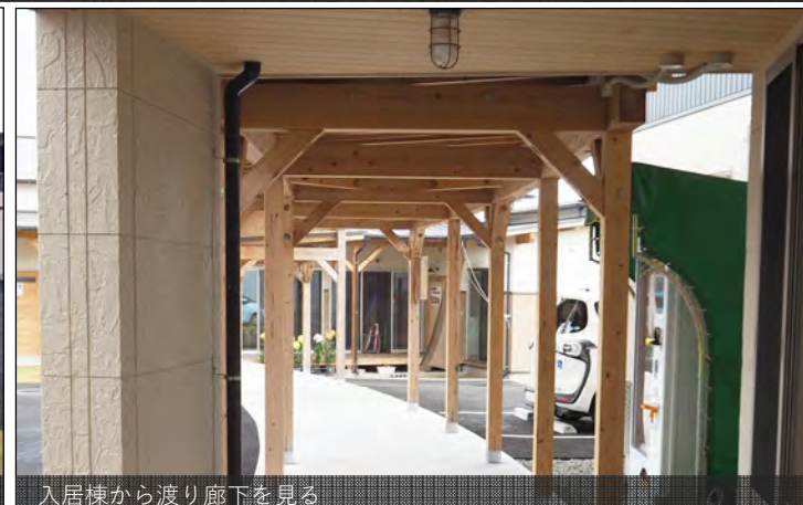
入居棟から渡り廊下を見る
