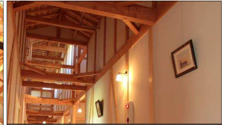
廊下から小屋組みを見る
