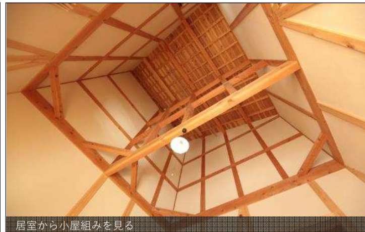
居室から小屋組みを見る
