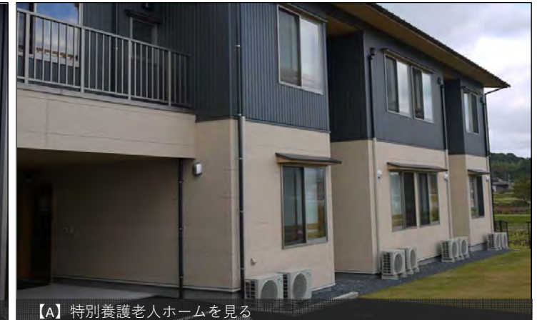
【A】特別養護老人ホームを見る
