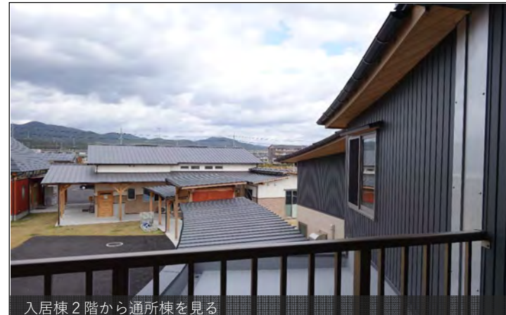
入居棟2階から通所棟を見る
