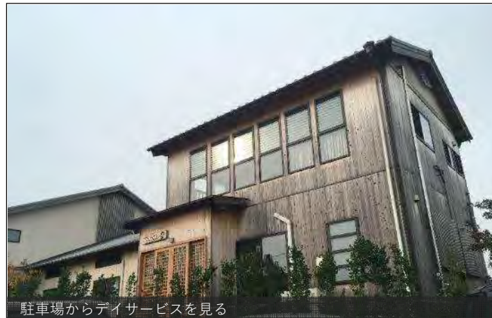
駐車場からデイサービスを見る
