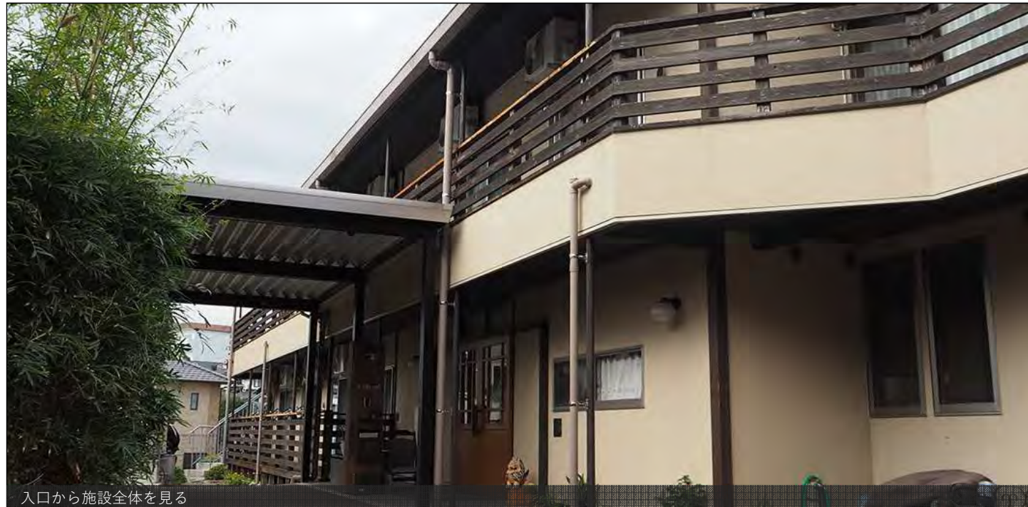
入口から施設全体を見る
