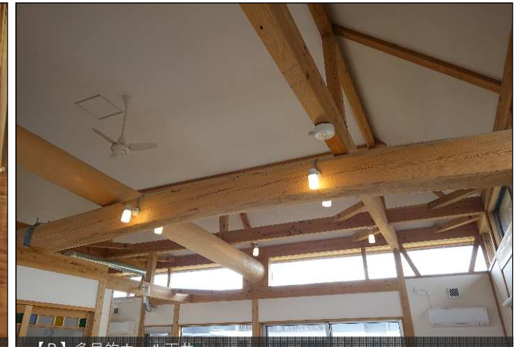
【B】 多目的ホール天井
