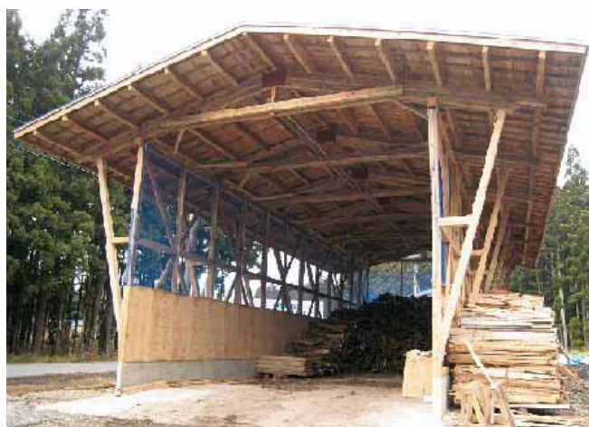
図 3.1-9 燃料用の木質バイオマス貯木場
