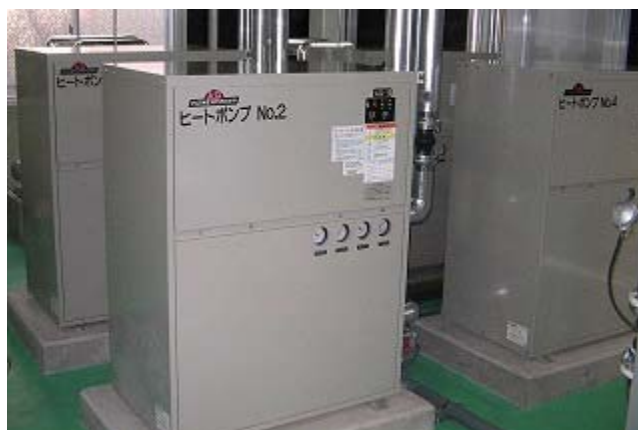
図 3.1-15 地下水利用型ヒートポンプ
