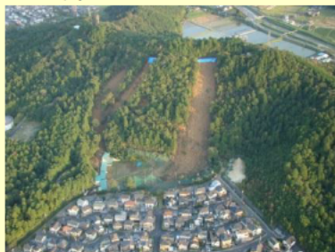
山腹崩壊の発生状況
