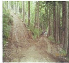
作業道・作業路の作設
