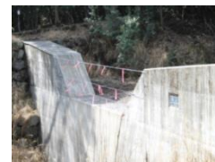
土石流センサーの設置
