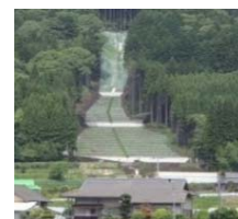
豪雨により発生した山腹崩壊地の復旧
