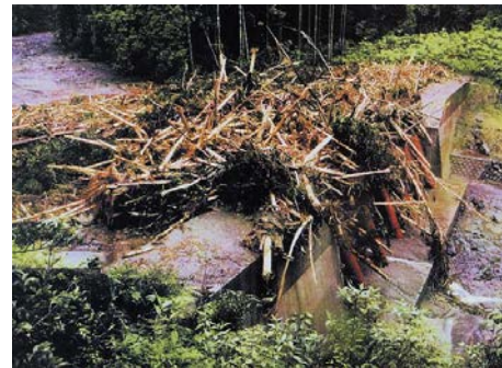
流木捕捉式治山ダムの設置
