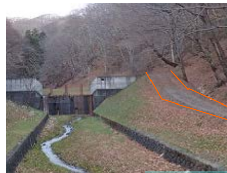
管理道の設置
