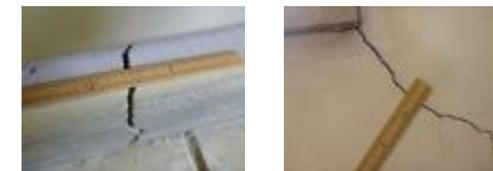
地面が沈下し建物がゆがみ、各所に亀裂が生じている特殊実験棟
