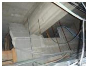
天井内コンクリ壁の倒壊
