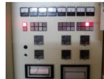
基盤等の破損により漏電警報ランプのみ作動
