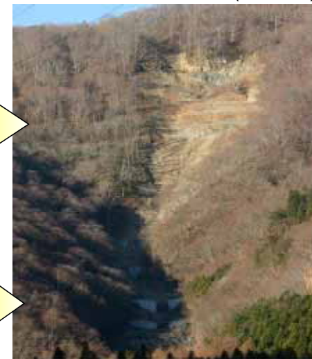
復旧整備状況(H16.11)
