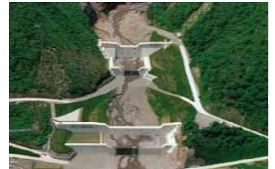
発生源を抑える国有林治山ダム
