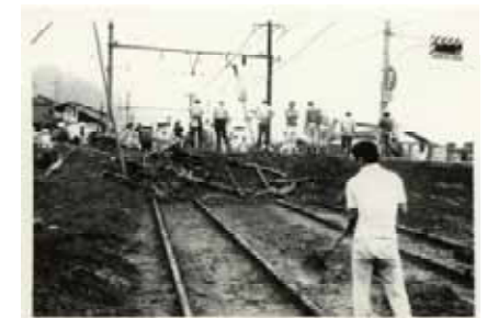
崩壊した土砂が東海道線に流入
