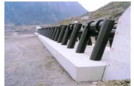
土石流拡散等を防止する民有林治山ダム
