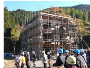
実証的 CLT 建築の現場における構造見学会
