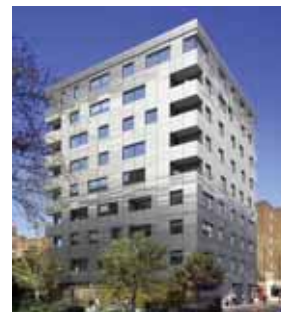
英国ロンドンで、CLT を用いて建築された集合住宅 （木造9階建て。ただし、1階部分は鉄筋コンクリート造）
