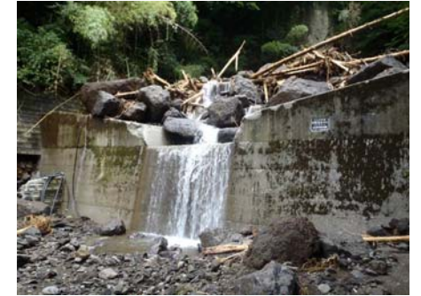
治山ダムによる土砂の捕捉状況 (熊本県阿蘇市)
