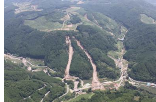
山地災害被害の様子 (福岡県八女市)
