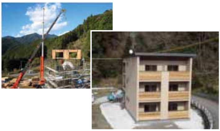
CLTを構造材として活用した国内第一号の建築物 (高知県)
