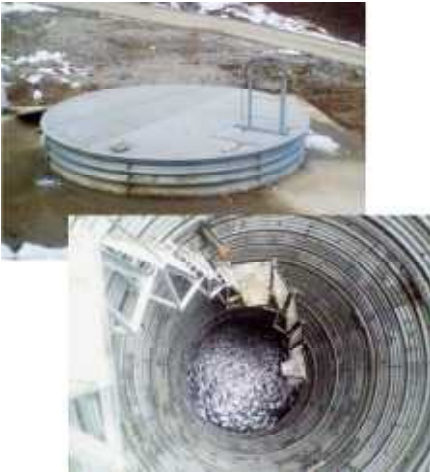
集水井工（外観及び内部）
