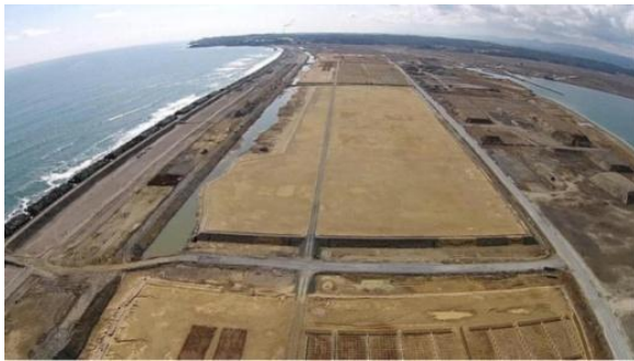
生育基盤の造成が完了した海岸防災林
