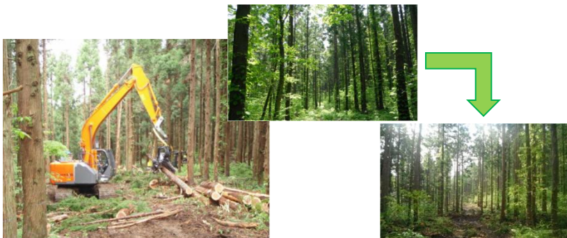
高性能林業機械を活用した間伐事業
