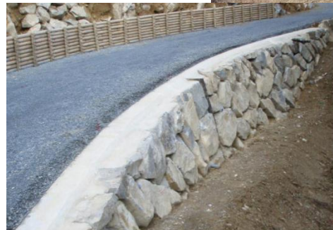
木柵工と、現地発生転石を活用した練石積
