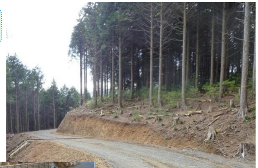
土工量低減のため切土高を低く抑えた路網
