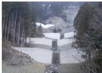
国有林内に設置した溪間工
