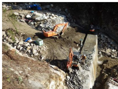
既存治山ダムの嵩上げ工事
