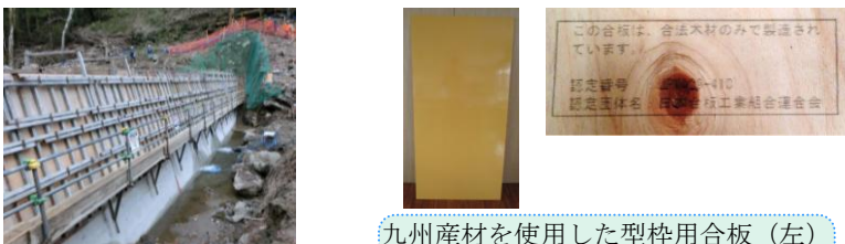
型枠用合板を活用した谷止工
