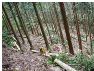
民有林の保安林整備後の様子
