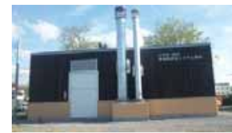
木質バイオマス熱利用施設
