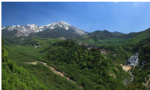
おんたけ 「御 岳の土石流跡に緑を甦らせた長野県西部地震災害復旧」 （後世に伝えるべき治山～よみがえる緑～） 昭和59年の被災直後（上）と現在（下）の様子（中部森林管理局）
