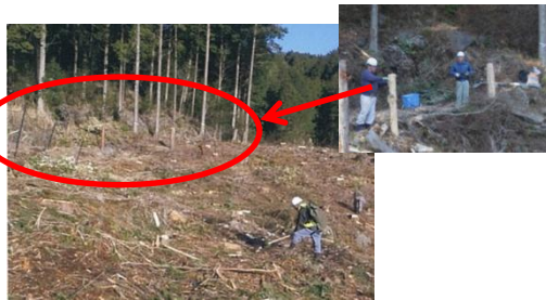
防鹿網の設置及び植栽の様子
