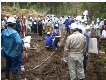
森林作業道作設の現地検討会
