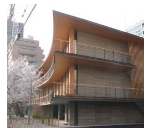
耐火建築物の事例
