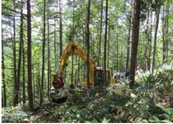
高性能林業機械による 路網作設の様子
