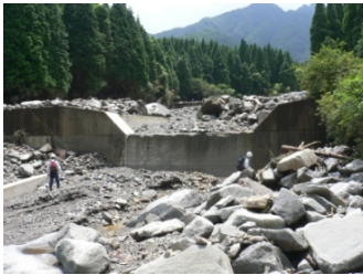
災害発生後の現地調査の様子
