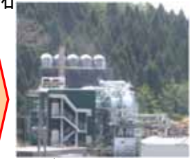
バイオマス発電所
