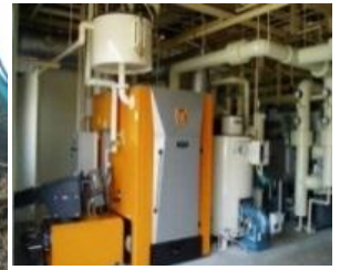
熱供給施設等での利用
