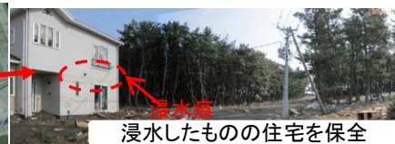
浸水したものの住宅を保全
