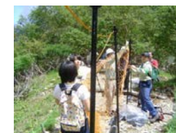
防護柵の設置の様子
