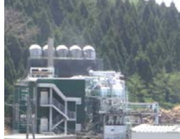
バイオマス発電所
