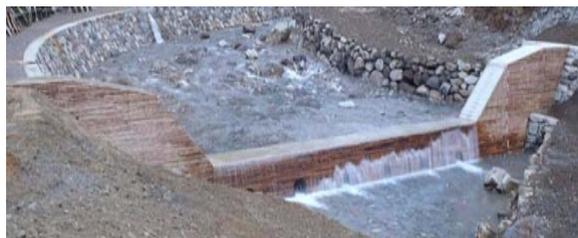
木材利用の推進のため丸太型枠を残して施工された谷止工
