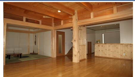
【大径木を使用した居間】
