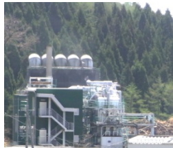
バイオマス発電所
