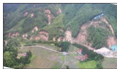
ヘリコプターによる上空からの調査
