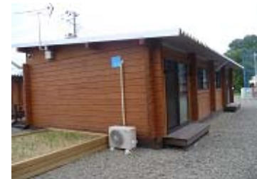
地元国有林材を利用した仮設住宅(福島県二本松市)
