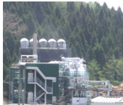
バイオマス発電所
