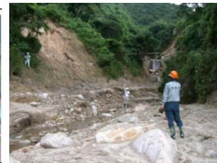
地上からの災害調査
