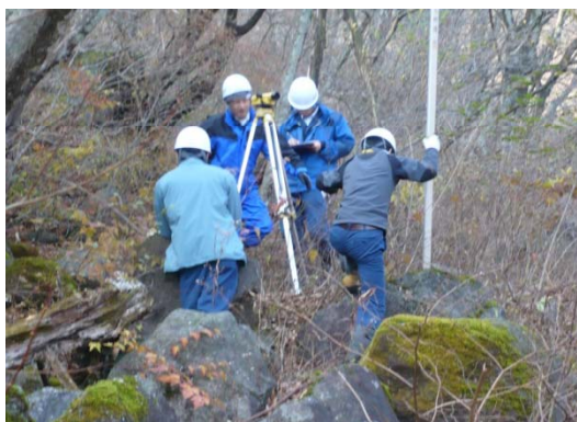
治山工事のための測量研修
