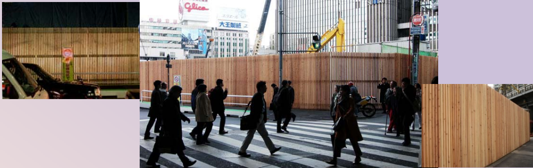
工事用仮囲い
