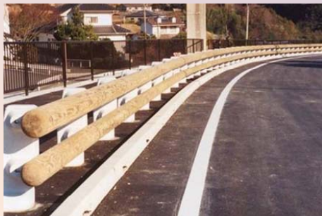
ガードレール
