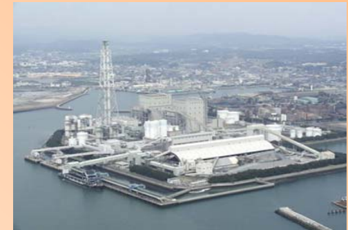
石炭火力発電所での混合利用
