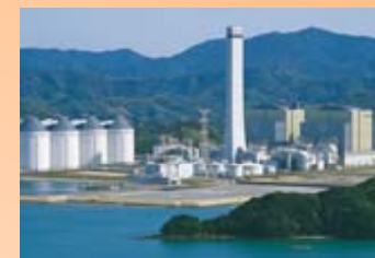
石炭火力発電所での混合利用
