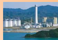
石炭火力発電所での混合利用
