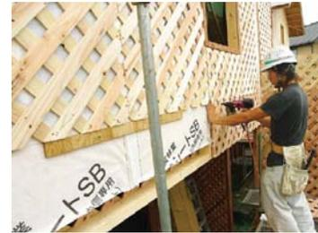
S社では、スギの小幅板を格子状に張り合わせた耐力面材（写真）やヒノキ集成材を開発・使用。平成20年には主要構造材の国産材比率70%を達成。平成21年の国産材取扱量は70万m<sup>3</sup>。
