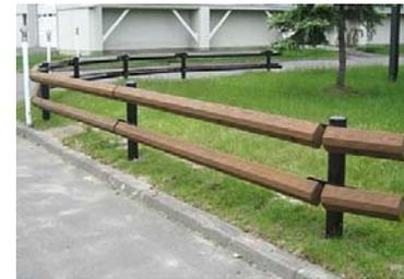
北海道等は、雪が積もらないように部材を傾けた耐雪性の高いタイプを開発（写真：北海道型）。
