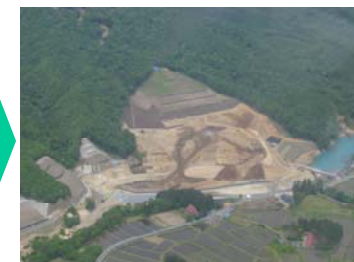
災害復旧工事施工中
