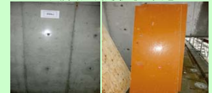
12回転用した国産材型枠とこれを活用した間仕切り壁(たわみ・はらみに問題なし。)
