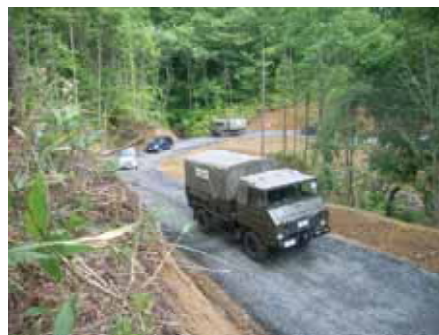
写真：孤立した集落への交通確保のため、迂回路となる林道を緊急整備
