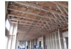
製材による大規模トラス
