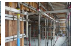
実証施工の様子
