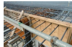
国産材コンクリート型枠用合板 (北陸新幹線工事)
