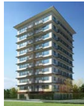
10階建て木造賃貸住宅【宮城県】
