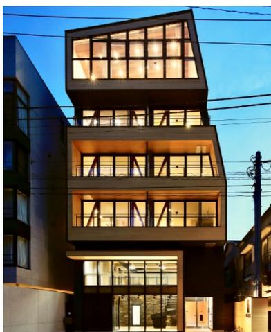
鉄骨造+木造軸組工法による
