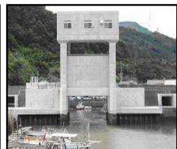
津波・高潮対策としての水門整備
